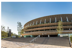
国立競技場(当社設計・施工)
