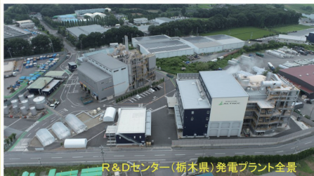
R&amp;Dセンター（栃木県）発電プラント全景
